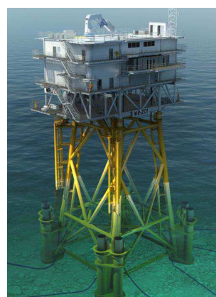
P33 – Sous-station électrique
