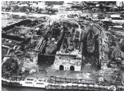
Brest 1946, les travaux des bassins de Lanignon.
