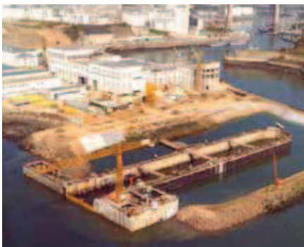
Construction du bassin 10 dans l'arsenal de Brest, 1972.
