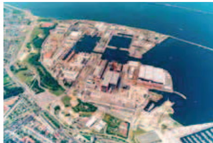
Vue aérienne de l'arsenal de Cherbourg, après refonte du secteur « Constructions ».
