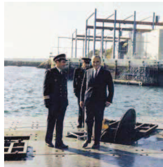
M. Pompidou à l'Île Longue en 1971, au fond l'entrée des deux bassins.
