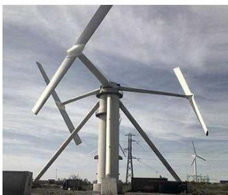
Du côté des énergies marines renouvelables, le premier prototype d'éolienne à axe verticale Vertiwind est en cours de construction à Fos sur Mer. Ce premier test à terre permettra de qualifier la technologie pour son déploiement futur en mer sur fondation flottante. ([Natura Sciences](#))
